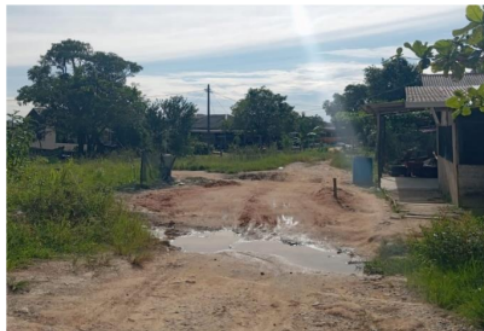
Gambar 13 Kondisi jalan menuju objek wisata Pantai Batu Gajah
