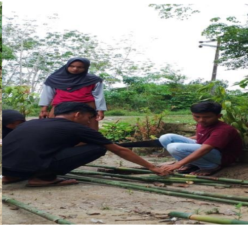
Gambar: Pengukuran dan pemotongan bambu
