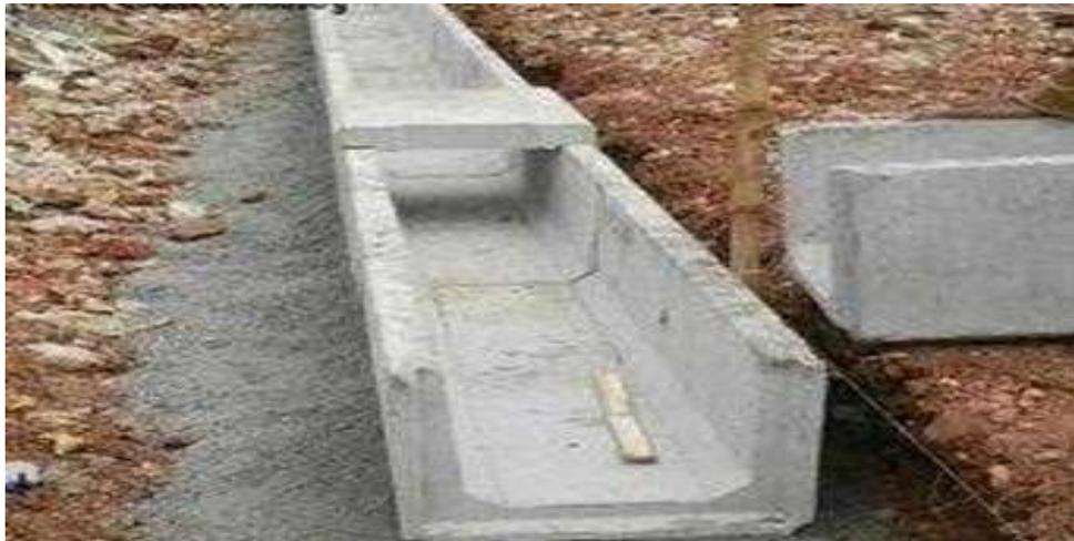
Seperti halnya kanstin, *drainage* atau saluran air ini juga harus sudah di pasang sebelum pemasangan paving dilakukan. Hal ini sangat wajib dilakukan untuk efisiensi waktu/kecepatan pekerjaan. *Drainage* yang dikerjakan setelah paving terpasang akan sangat mengganggu pekerjaan pemasangan paving itu sendiri karena harus membongkar paving yang sudah terpasang.
